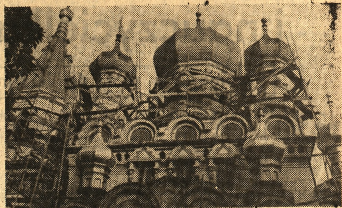
W Hrubieszowie (Zamojskie) trwają prace konserwatorskie przy cerkwi pochodzącej z końca XIX w. W przyszłym roku obiekt ten ma być udostępniony zwiedzającym. Na zdjęciu: — fasada zabytkowej cerkwi.
