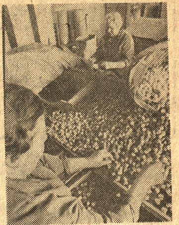
Poznańskie Zakłady Wyróbów Korkowych produkują kilkanaście rozmiarów korków do butelek. Najmniejszymi (6 mm) za mykane są buteleczki z olejkami do wypieku ciast, a największymi (100 mm) termosy. Na zdjęciu: podcięcie sortowania korków.
