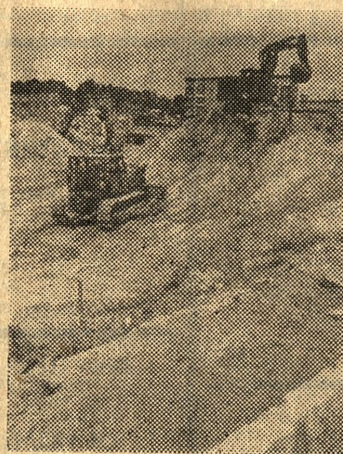
Na zdjęciu: głębokie wykopy na budowie „trasy niestachowskiej”. Fot. — R. Królik
