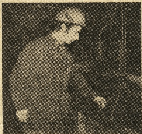
Jedno z archiwalnych już zdjęć w prywatnych zbiorach T. Błażejewskiego. Rok 1972 — sprawdzanie wymiennika ciepła przed jego zamontowaniem w lokomotywie.
