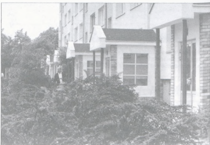
Ocieplone budynki z dobudowanymi wiatrolapami w otoczeniu bujnej zieleni prezentują się wspaniale.
