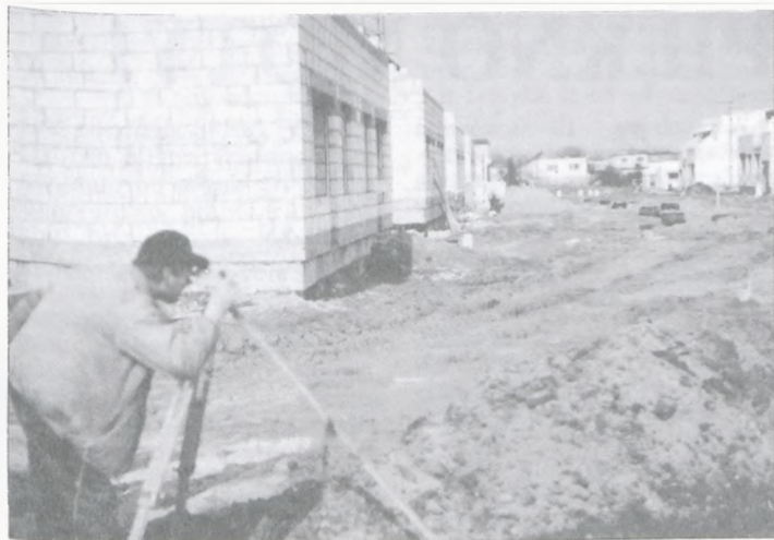
Z kalendarzową wiosną ruszyły prace na placu budowy domków jednorodzinnych na os. Działyńskiego Fot. R. Tomaszewski
