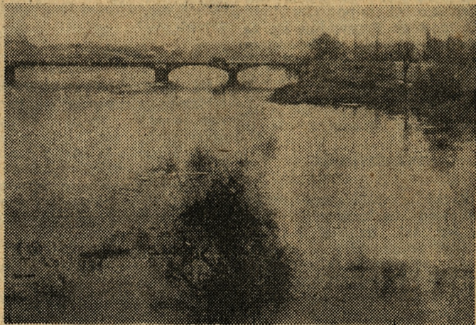
Warta w Poznaniu na odcinku między mostem Marchlewskiego i mostem Rocha.
