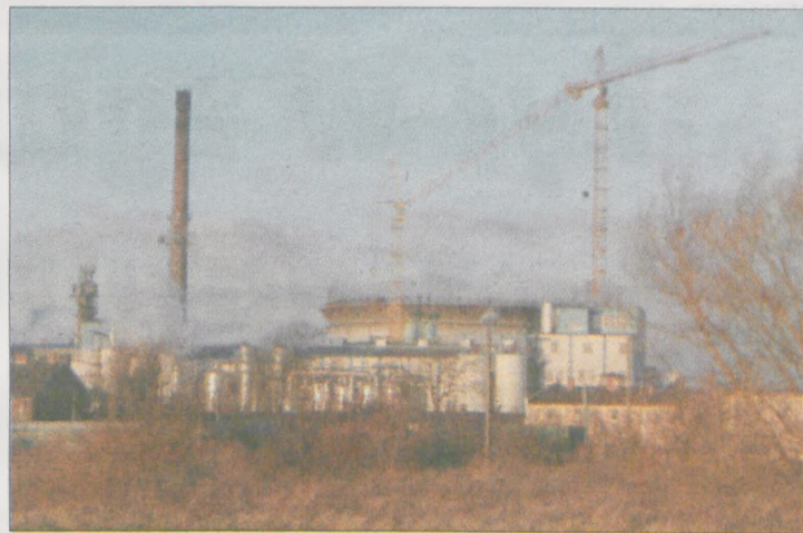
Silos zaczyna powoli górować ponad budynkami cukrowni, a za miesiąc będzie wysoki jak stojący obok komin.
