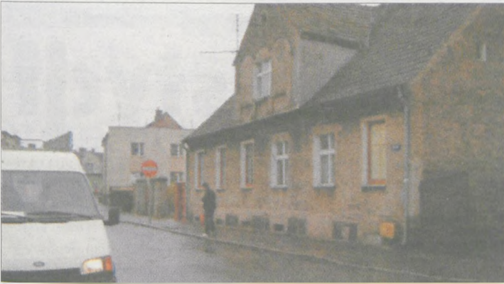
Budowa kolektora w ul. Dolnej
