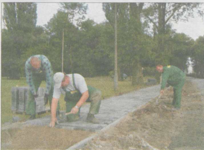
Słupia Wielka - remont drogi powiatowej
