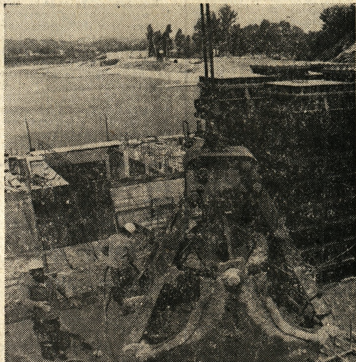
Trwają prace przy budowie zbiornika i zapory wodnej na Rabie w Dobczycach koło Krakowa. Zbiornik będzie stanowił rezerwę wody dla miasta, a ponadto pozwoli na skuteczne regulowanie przepływu rzeki i tym samym zabezpieczy okoliczne tereny przed powodzią.
