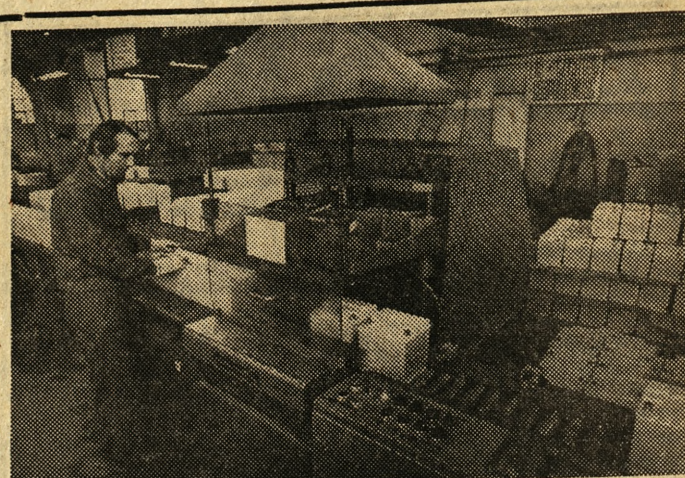
Poznańskie Zakłady Elektrochemiczne „Centra”: linia do zgrzewania akumulatorów 45 Ah.
