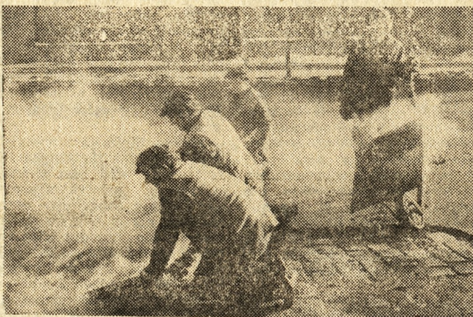
Mimo niskiej temperatury pracownicy Rejonu Dróg Publicznych naprawiają uszkodzone jezdnie. Na zdjęciu: prace na ul. Garbary. Fot. — R. Królak
