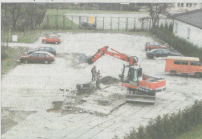
Pracownicy „Trans - Maszu” naprawiają od wtorku nawierzchnię parkingu za budynkiem byłej „Spójni”.
