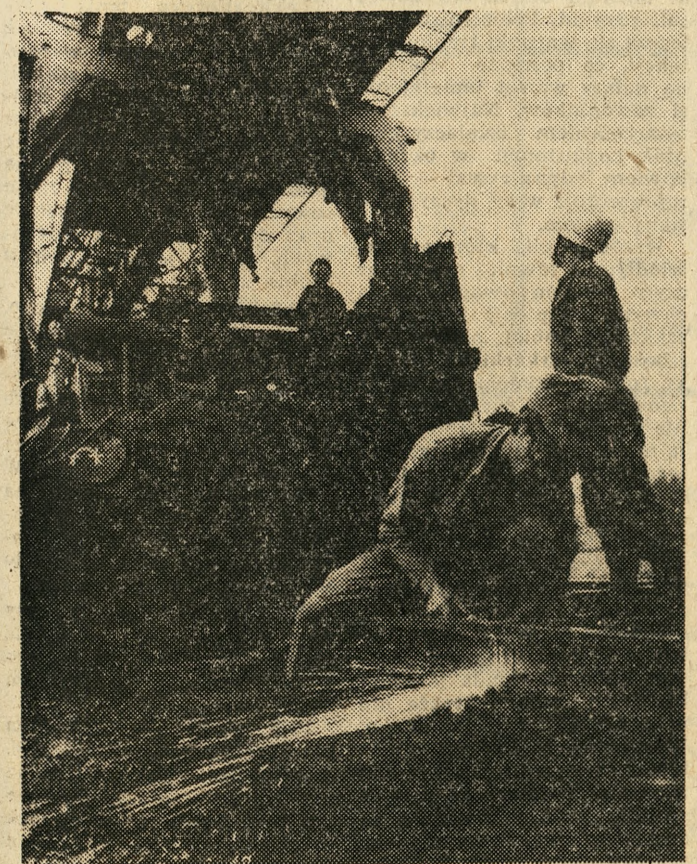
Żołnierze z jednostek kolejowo-drogowych okazują dużą pomoc przy modernizowaniu żelaznych szlaków w Wielkopolsce. CAF — fot. Sobieszczyk
