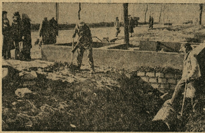
Na trasie E-8 powstają poczekalnie dla pasażerów przy przystan- kach autobusowych. Na zdjęciu: prace przy jednej z czterech poczekalni w okolicach Wrześni.
