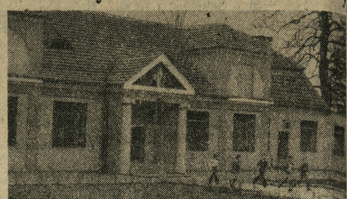
Stara wozownia po remoncie coraz lepiej służy kulturalnym po- trzebom mieszkańców Nekli (Poznańskie).
