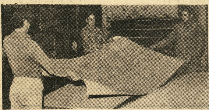
Brygada Jacka Tomaszewskiego przygotowuje płyty do oklejania folią papierową.
