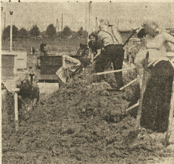
Podczas prac na terenie powstającej w Lesznie stacji paliw CPN.
