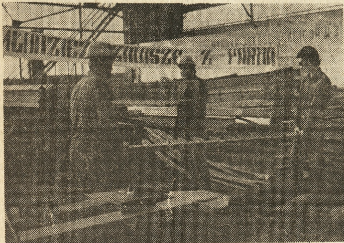
W słupskim „Mostostalu” w województwie konińskim, pracowano przy malowaniu konstrukcji przeznaczonych na budowę zakładów przemysłu spożywczego.
