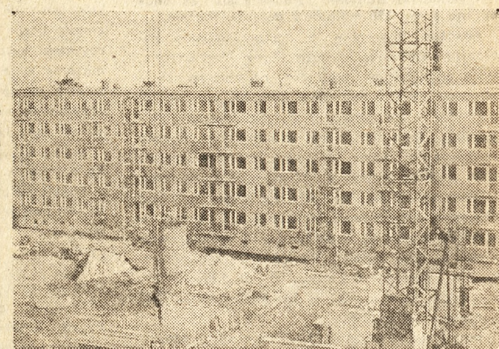
Rośnie osiedle mieszkaniowe im. H. Sienkiewicza w Kole. Błok nr 9, którego budowa dobiega końca, zostanie wkrótce zamieszkanym przez lokatorów. Na zdjęciu: fragment tego bloku. (za) Fot. — H. Kamza
