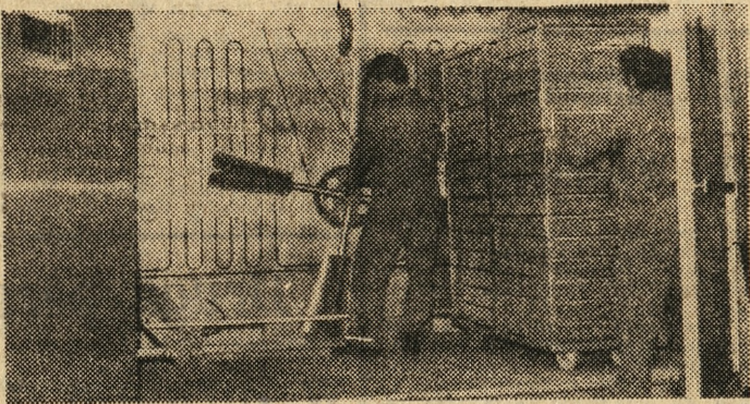
Ostatni etap montażu komór kłujnikowych. Tu będą się „rodzić” kurcząt.
