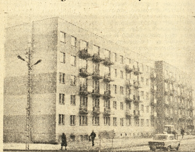
Przy placu Wiosny Ludów w Ujściu (województwo piłskie) oddano do użytku i częściowo otynkowano (obecnie kończy się elewację od strony podwórza) blok mieszkalny dla pracowników miejscowej Huty Szkła
