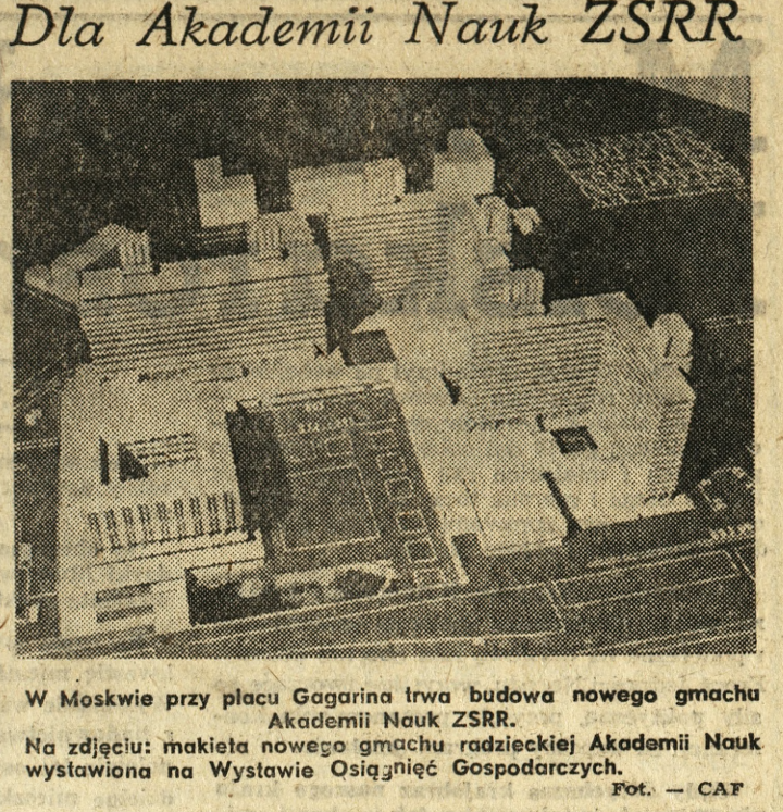
W Moskwie przy placu Gagarina trwa budowa nowego gmachu Akademii Nauk ZSRR. Na zdjęciu: makietka nowego gmachu radzieckiej Akademii Nauk wystawiona na Wystawie Osiągnięć Gospodarczych. Fot. — CAT
