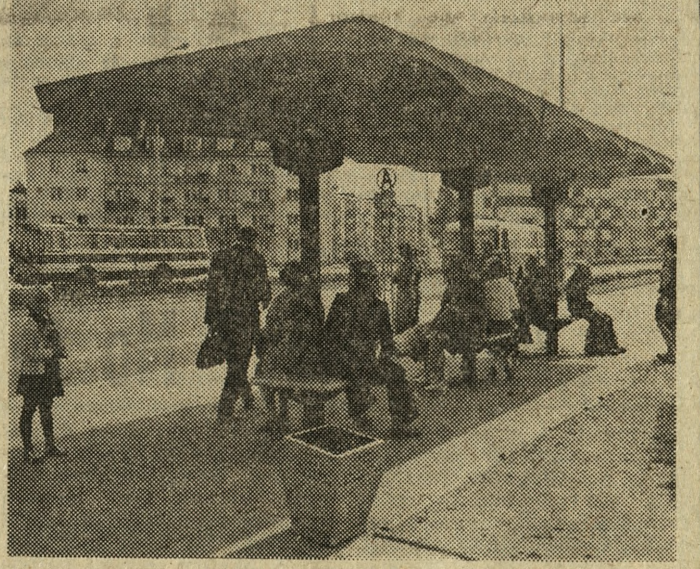
W Pile na wszystkich przystankach komunikacji miejskiej ustawiono kolorowe wiaty chroniące przed deszczem. Fot. — B. Kościecha
