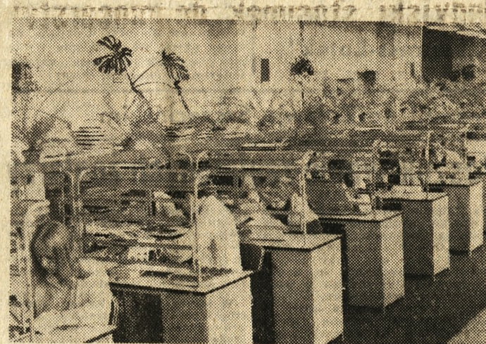
Hala montażu w poznańskiej „Teletrze”.
