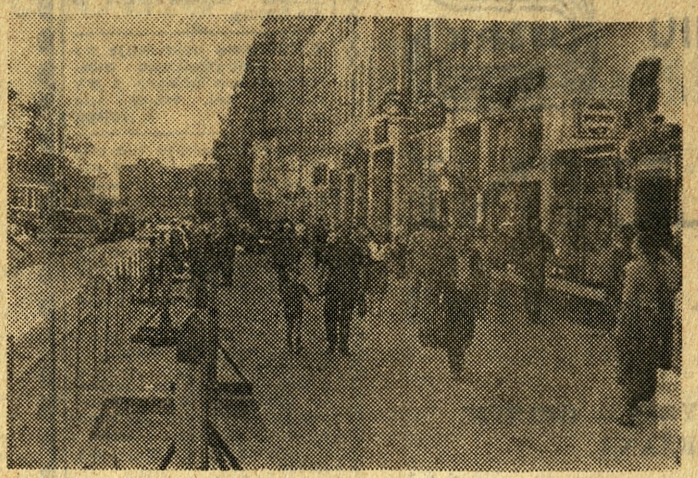
Trwa przebudowa ulicy 27 Grudnia. Oto fragment nowego deptaku, niezbędnego w tym rejonie miasta.
