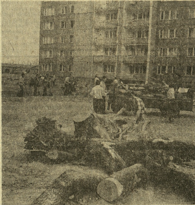
Przedstawiciele Spółdzielni Mieszkaniowej „Grunwald” pracowali m. in. przy budowie boiska sportowo-rekreacyjnego na Osiedlu Kopernika.
