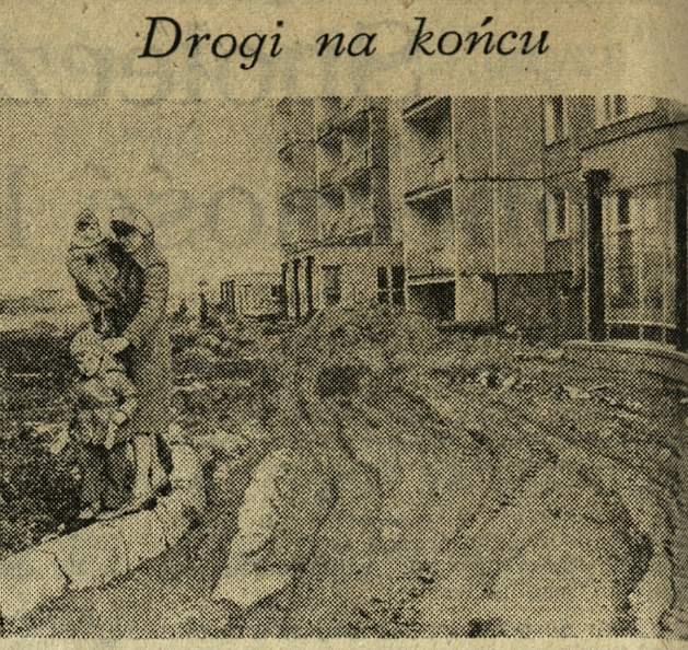
W blokach na Osiedlu im. Mikołaja Kopernika przy ul. Gallileusza zasiedliny odbyły się dość dawno, a budowa dróg wyglądała tak jak na zdjęciu. Fot. — K. Przychodźki
