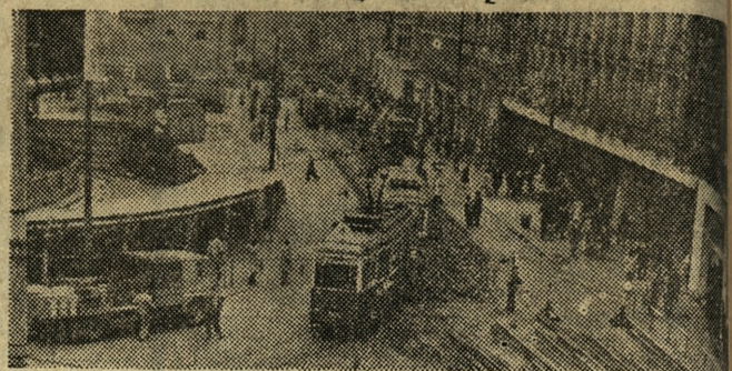
Trwają roboty drogowe przy modernizowaniu ulicy 27 Grudnia. Mimo utrzymanego ruchu tramwajowego, postępują one szybko. Ma tam powstać — jak już informowaliśmy — deptak. Fot. — H. Kamza
