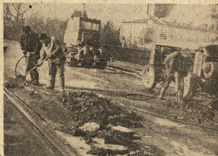
Trwa wymiana nawierzchni jezdni na Trasie Chwaliszewskiej. Na zdjęciu: brygada Adama Mikolajczaka w akcji.
