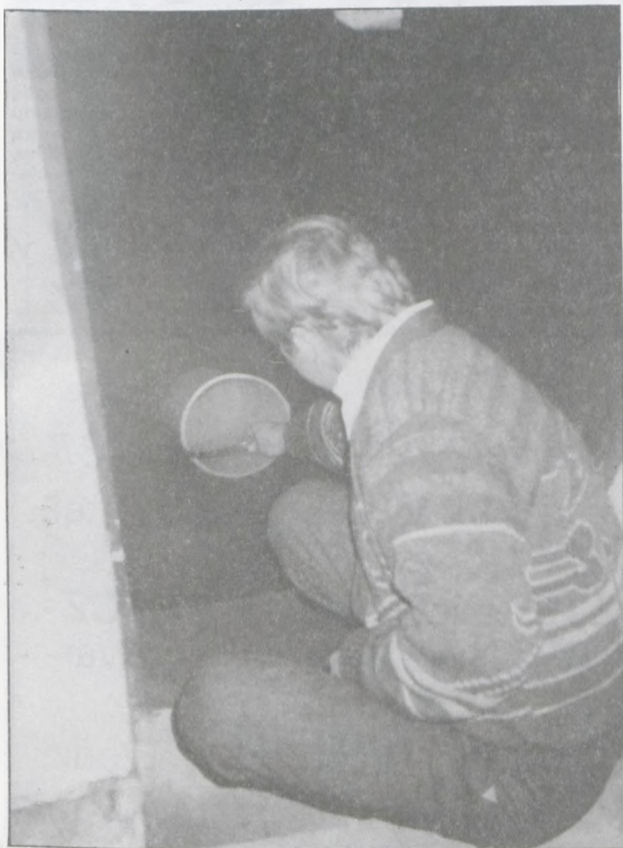
Na ul. Kórnickiej wodę z piwnicy wybiera się z mizernym skutkiem wiadrami. Fot. R. Belecki
