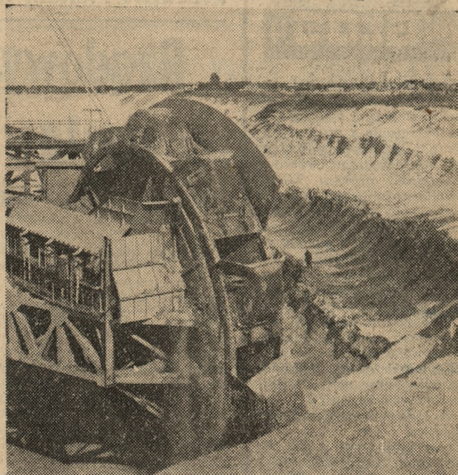
Gigantyczna koparka pracująca w Kopalni Węgla Brunatnego w Bełchatowie zbiera w ciągu doby 100 000 metrów sześciennych nadkładu. Tym samym zbliża się do zdolności docelowej — 110 000 metrów sześciennych.
