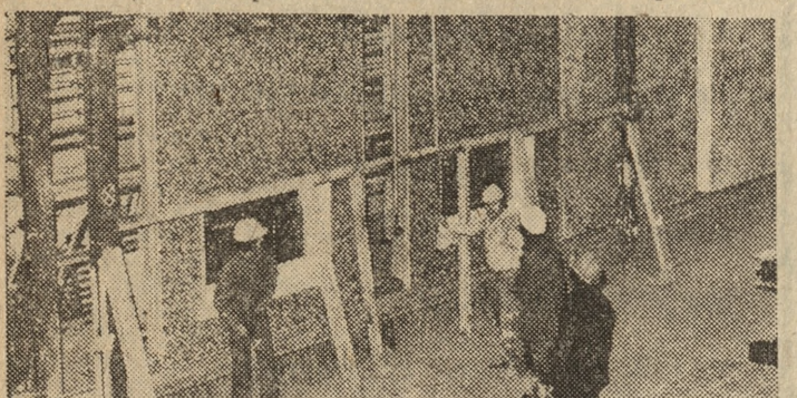
Na zdjęciu dolnym: brygada Czesława Karpińskiego przy wyjmowaniu gotowego elementu ściany zewnętrznej z linii wykańczalni. Zdjęcie powyżej przedstawia widok ogólny fabryki.
