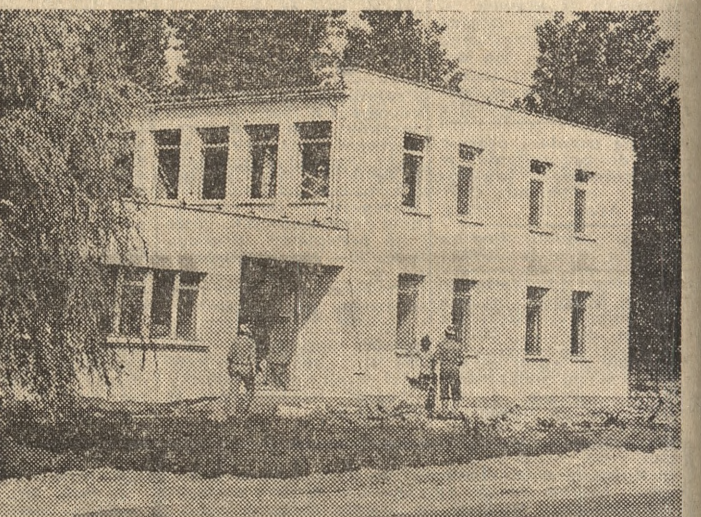
Na zdjęciu: fronton modernizowanego gmachu dla Urzędu Gminnego.
