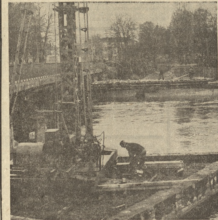
Pracownicy brygady Oddziału Robót Mostowych przygotowują katar do wbijania pali na których stanie most na Gwdzie w Pile. Fot. — B. Kościecha
