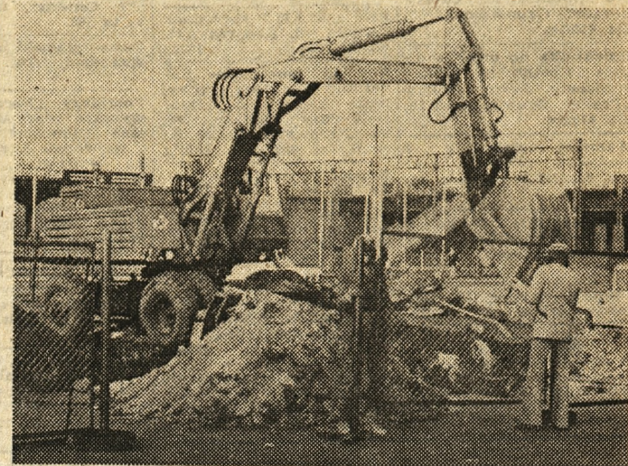
Trwają prace przy modernizacji placu przed Dworcem Głównym PKP w Poznaniu
