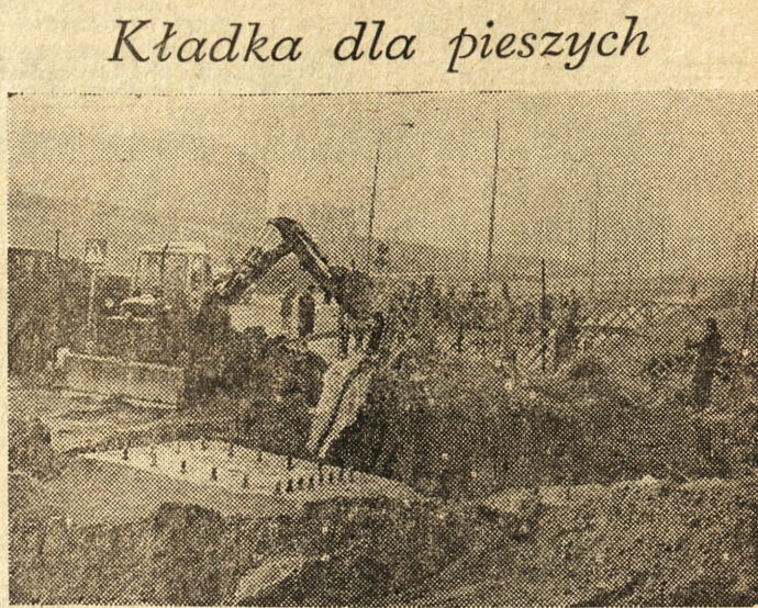
Trwa budowa kładki dla pieszych nad jezdnią ulicy Stowiańskiej (w pobliżu „Supersamu”). Wiosną przejście to ma być oddane do użytku.
