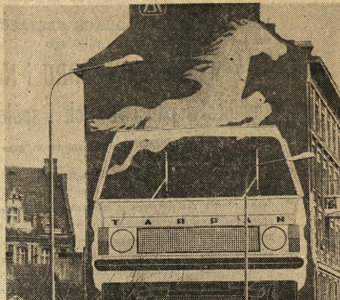
Zniknęły ruszłowania ze ściany szczytowej domu przy placu Wielkopolskim (narożnik ul. Działowej), na której pojawiła się reklama (na zdjęciu) produkowanych w Poznaniu „Tarpanów”. (za) Fot. — H. Kamza
