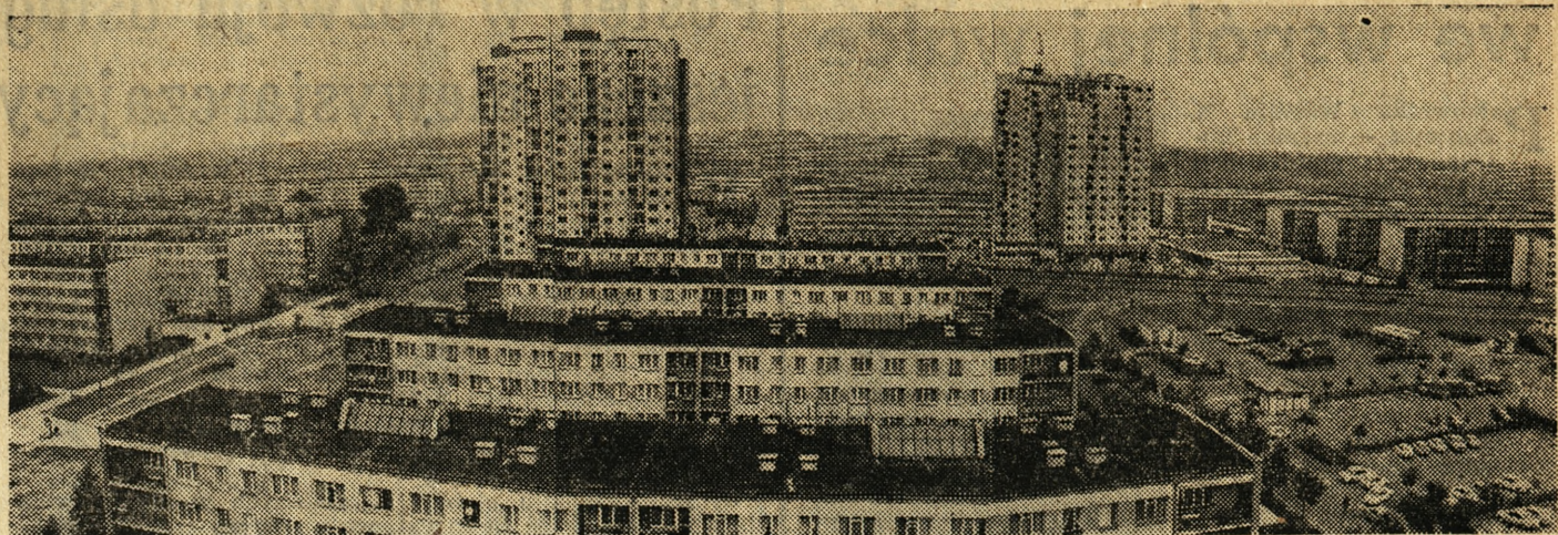
Na największym osiedlu Poznania Ratajach, mieszka już około 60 000 osób. Nad dolnym tarasem nowej dzielnicy miasta zaczyna górować wysokie 16-kondygnacyjne domy. Wszystkie montowane są z wielkich płyt produkowanych w wytwórni na Ratajach. Fot. — H. Kamza
