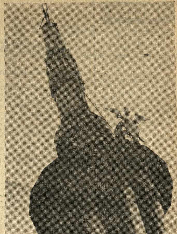
We wczorajszym numerze „Głosu” informowaliśmy o konieczności przeprowadzenia okresowej konserwacji orła z wieży poznańskiego Ratusza. Wczoraj przed południem Andrzej i Marian Pospieszni z Ostroroga, stosując opracowaną przez siebie metodę, dokonali demontażu i opuszczenia orła. Przypatrywało się temu wielu poznańców. Z kolei zostanie on poddany odpowiednim zabiegom w poznańskich Pracowniach Konserwacji Zabytków. Na zdjęciu: orzeł w trakcie opuszczania z ratuszowej wieży. Fot. — S. Ossowski
