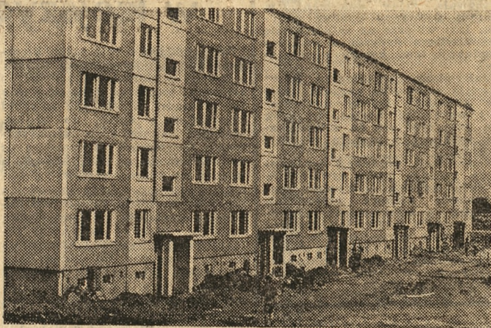
Na swarzędzkim osiedlu dobiegła końca budowa drugiego domu (na zdjęciu). Trzeci znajduje się w montażu, a przy czwartym trwają prace ziemne. Do 1980 roku w sumie ma powstać tutaj przeszło 1000 mieszkań.
