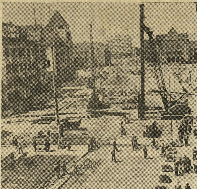
Tak przedstawia się ogólny widok przebudowy centrum Poznania.
