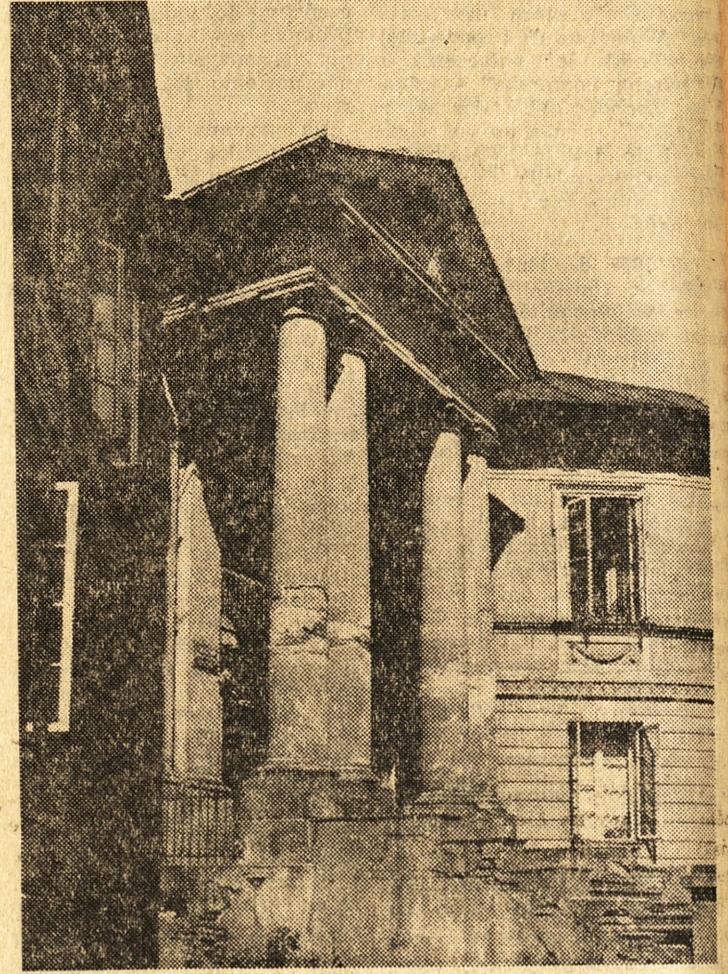
Fragment elewacji frontowej pałacu w Dobrzycy, nadgryzionej przez „zęb czasu”. Fot. — Archiwum
