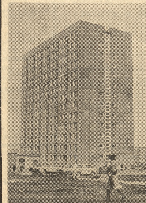
13 - kondygnacyjny dom na Osiedlu Kosmonautów 15, dla starszego poko-lenia, wybudowany jest przez Poznańskie Przedsiębior-stwo Budowlane nr 3.
