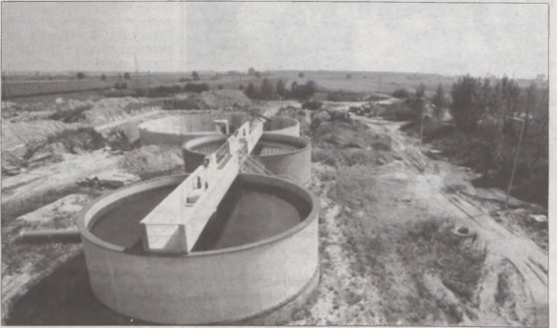
Miejska oczyszczalnia ścieków w Chwałkowie
