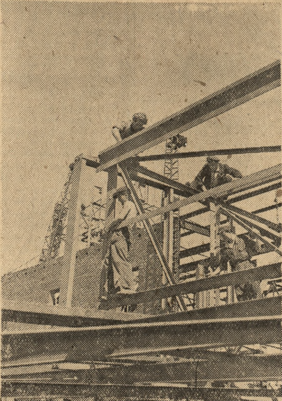
CAF — fot. Kondracki Budowa elektrowni w Jaworznie II postępuje szybko naprzód. — Na zdjęciu: Monterzy Jerzy Szaja, Tadeusz Birukow, Marian Gajek i Józef Lier — wykonują 145% normy przy montażu konstrukcji dachowej budynku głównego silowni
