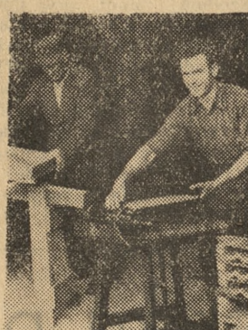
Wśród spółdzielców są fachowcy — samoucy. Oto Andrzej i Marian Burzyński (ojciec i syn) przy wyrabianiu chlebków na pokrycie obory, którą tarnowianie budują systemem gospodarczym. Wszystkie prace związane z tą budową (murarskie, ciesielskie, dekarskie, zbrojarskie i stolarskie) wykonują sami członkowie spółdzielni pod nadzorem technika budowlanego.
