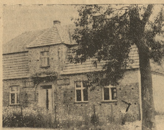
W ciągu niespełna dwóch lat pracy zespółowej spółdzielcy z Tarnowa (now. Oborniki) wybudowali piękny dom, w którym mieści się świetlica i przedszkole. Do przedszkola uczęszcza 27 dzieci.
