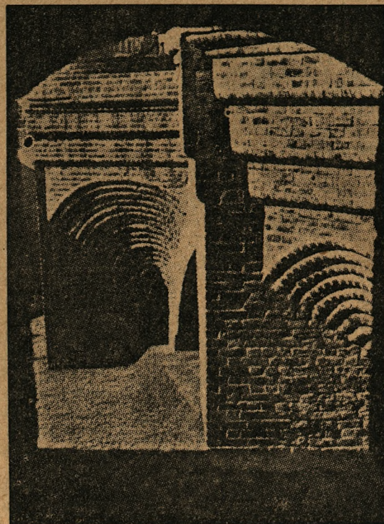
Odkopane mury średniowieczne
