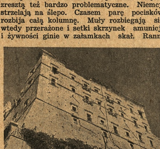
Północna ściana klasztoru
