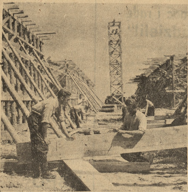
Fragment budowy Fabryki Samochodów Ciężarowych w Lublinie
