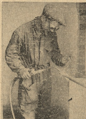
Spawacz Antoni Krysztofiak przy wykańczaniu wewnętrznych instalacji wodociągowych.
